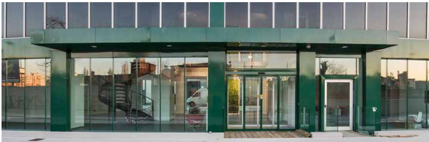
Palazzo della Cultura Tecniche Nuove: particolare porta scorrevole automatica d'ingresso Ponzi
