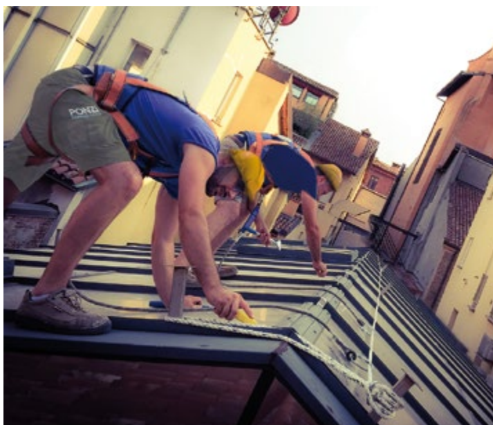
Installazione e posa di serramenti vetrati con pellicole di protezione solare
