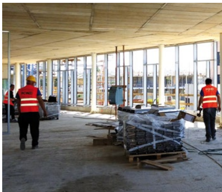
Montaggio realizzato dal personale PONZI con attrezzatura tecnica
