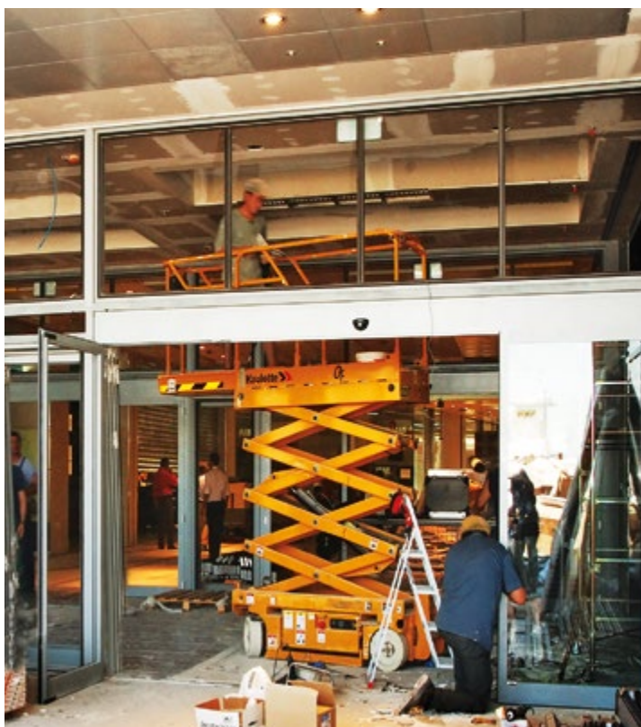
Installazione di porte automatiche e serramenti con idonea attrezzatura
