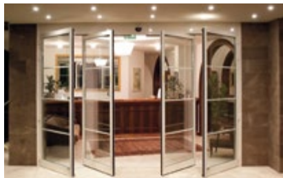
Verifica funzionamento sistema antipanico
