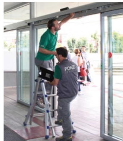
Sostituzione meccanismi esistenti obsoleti
