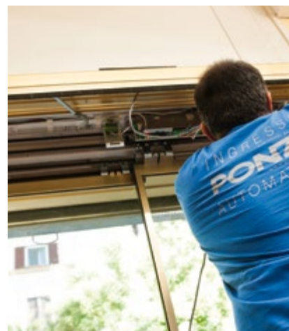
Adeguamento normativo porte automatiche
