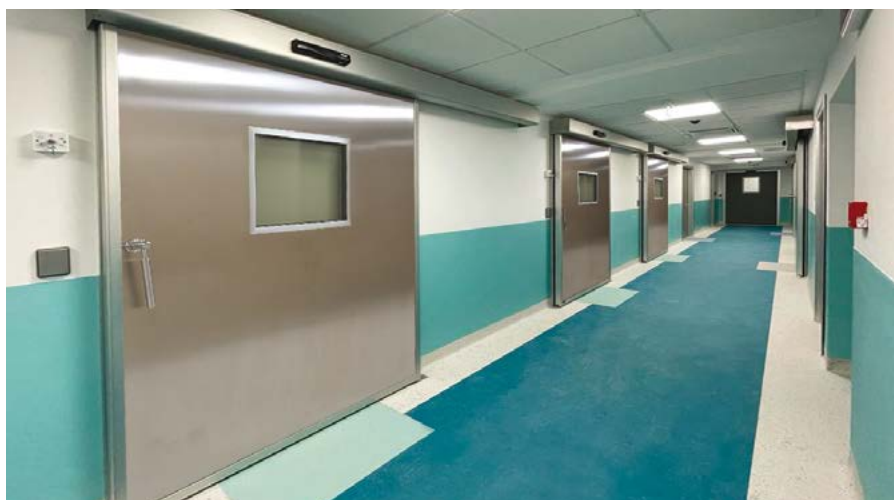
PSE Inox - Corridoio reparto operatorio, ante in acciaio inox con visive inserite
